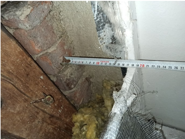
foto/9/ Pohled na provedenou sondu S1
