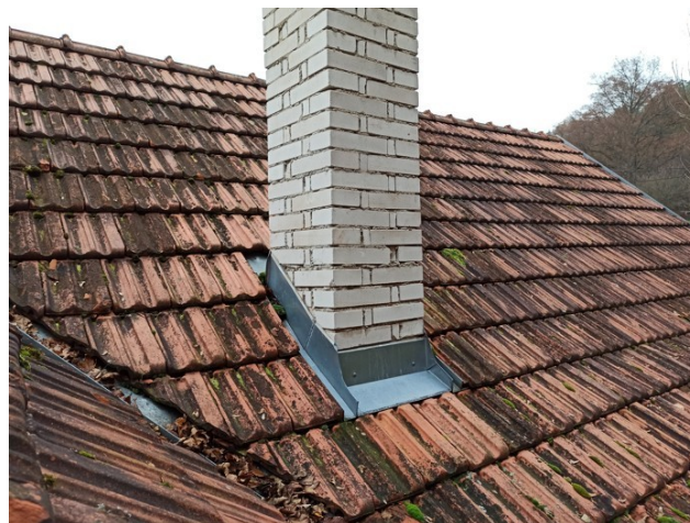
foto/4/ Pohled na předmětnou střešku
