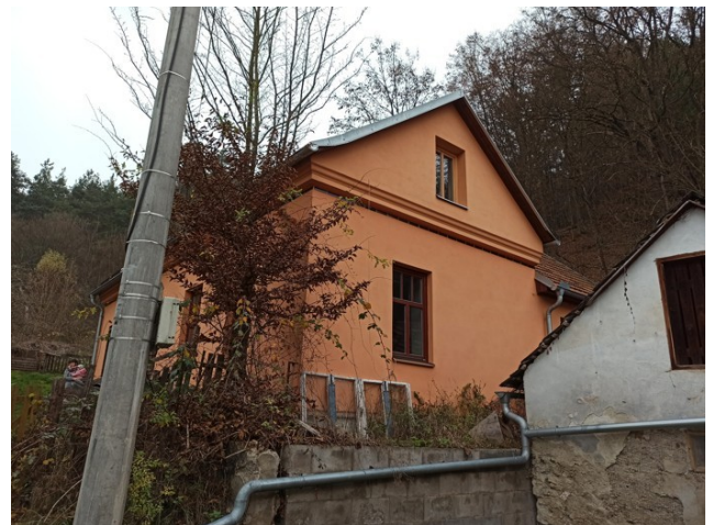
foto/2/ Pohled na předmětný objekt
