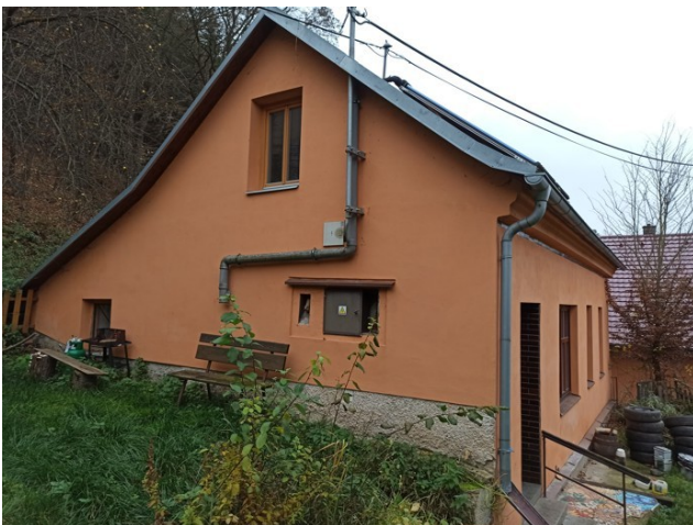
foto/1/ Pohled na předmětný objekt
