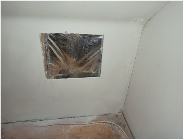
foto/7/ Pohled na provedenou sondu S1
