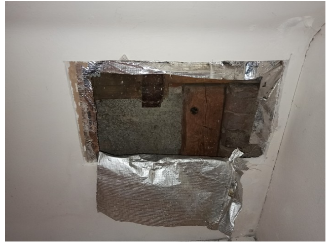
foto/8/ Pohled na provedenou sondu S1
