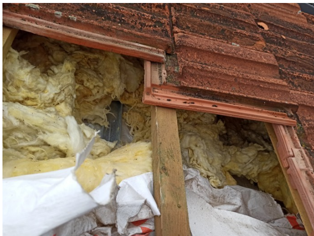
foto/11/ Pohled na provedenou sondu S2
